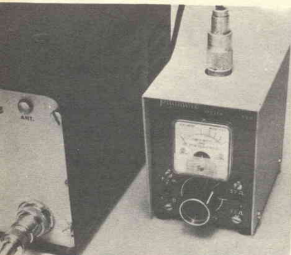
Strumento che serve sia come misuratore d'uscita sia come misuratore di intensità di campo.
